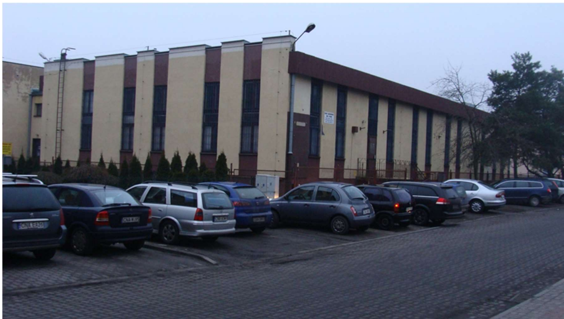
Fot. 5. Budynek, ul. Gimnazjalna 10
