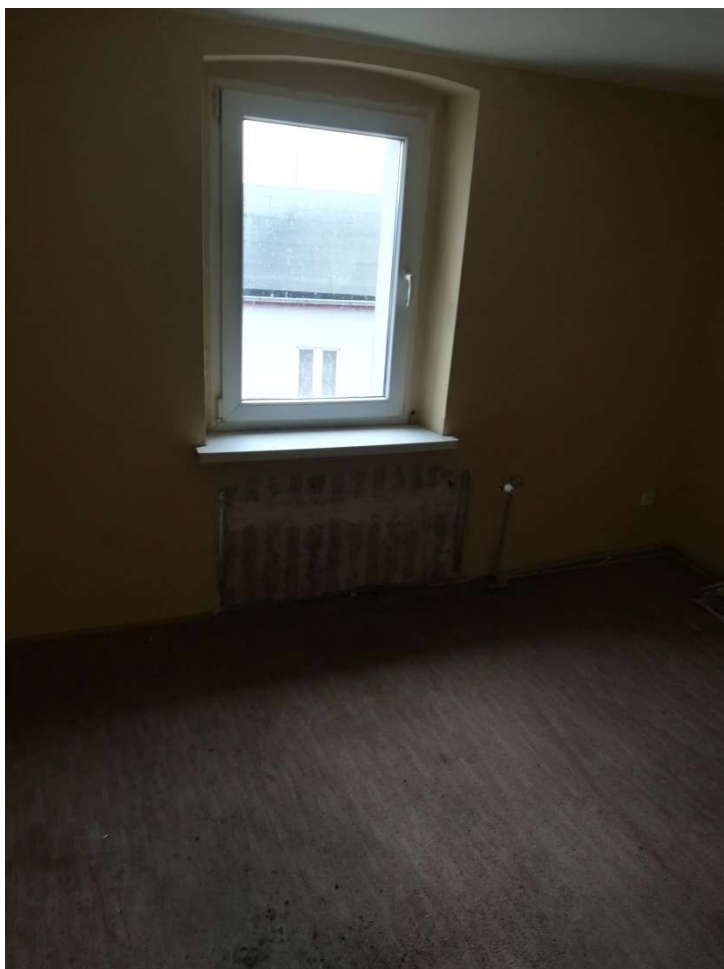
Fot.4. Budynek, ul. Wodna 7
