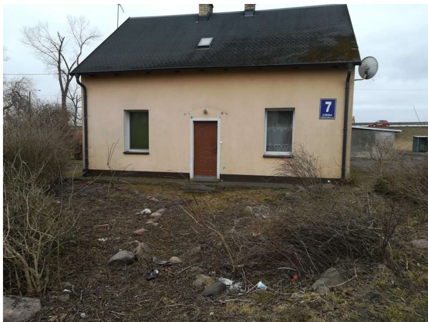
Fot.1. Budynek, ul. Wodna
