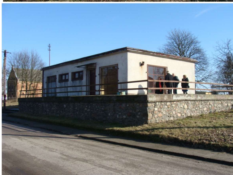
Fot. 8. Budynek w Kazinie
