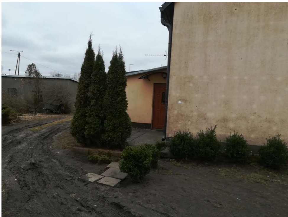
Fot.3. Budynek, ul. Wodna 7
