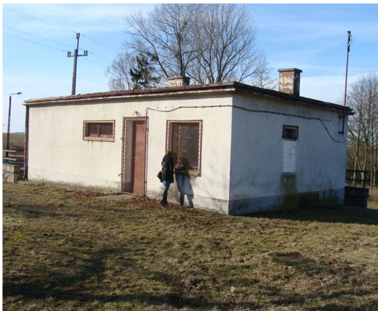
Fot. 7. Budynek w Kazinie
