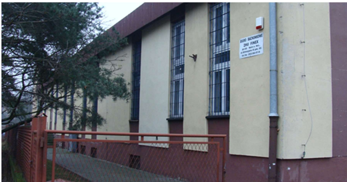
Fot. 6. Budynek, ul. Gimnazjalna 10
