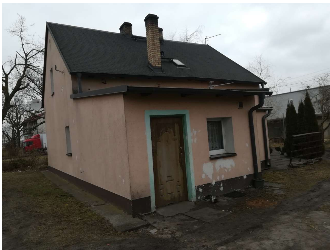
Fot.2. Budynek, ul. Wodna 7
